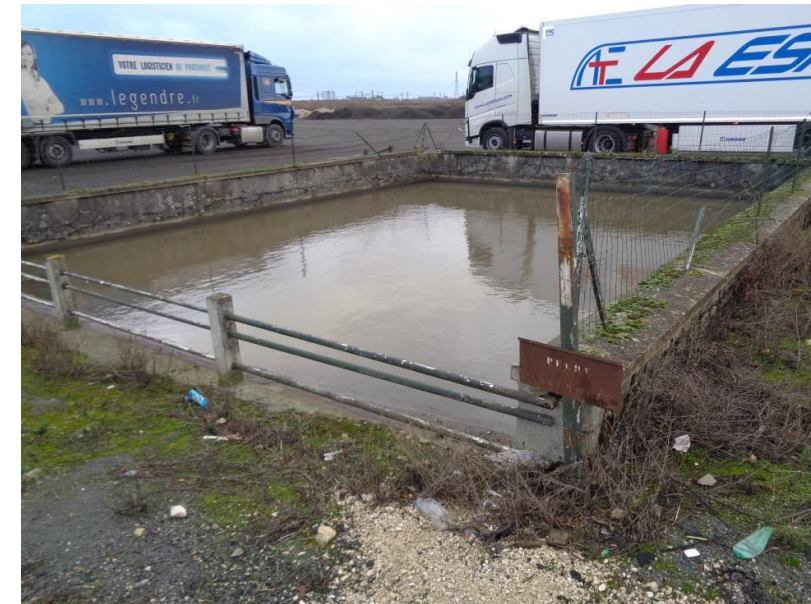
Figure 11 : Réserve incendie actuelle le long de la RD 2020 sur la commune de Barmainville (source : CD 28)
